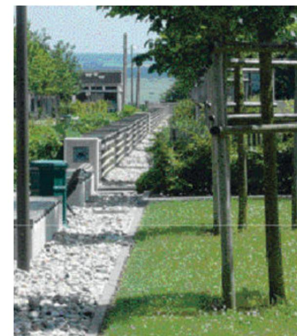
Exemple de tranchée d'infiltration
